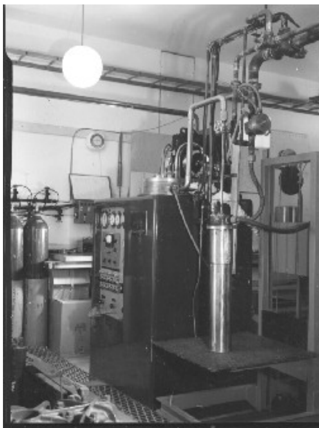
Helium maskin med egen tillverkad kryostat för experiment utanför maskinen 1956 Kurt Svensson
